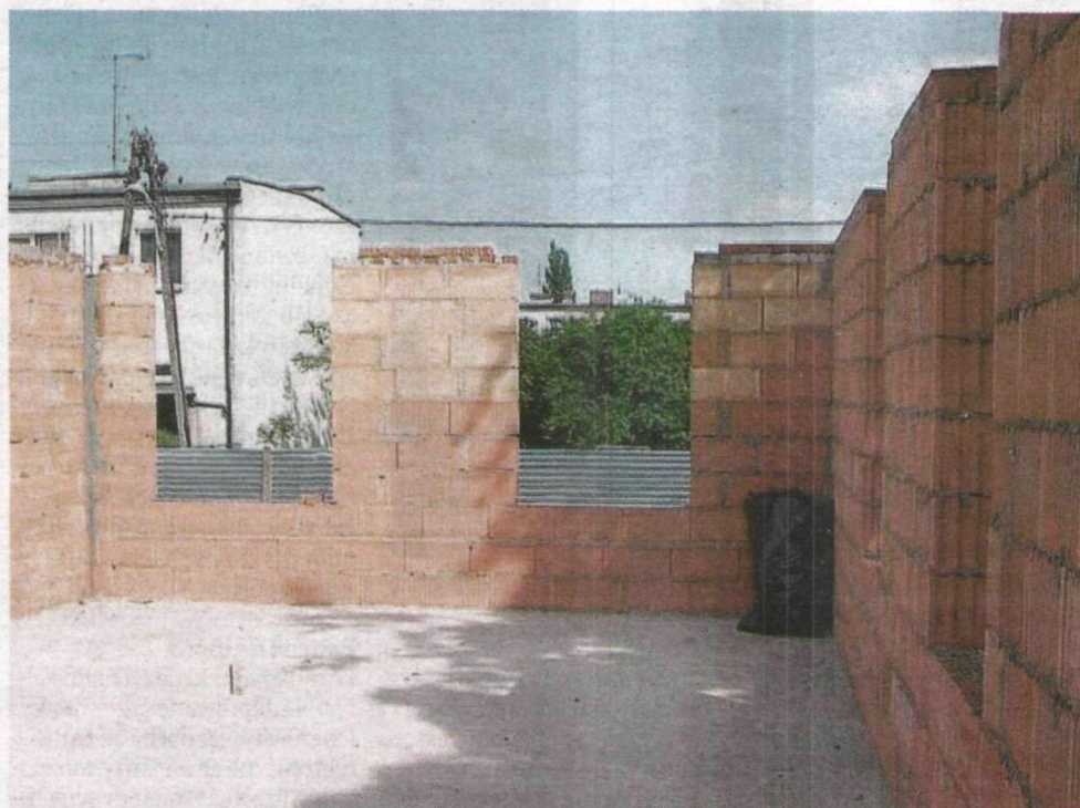
Koral zlokalizowany jest w obrębie dzielnicy Dębiec, w południowej części Poznania
