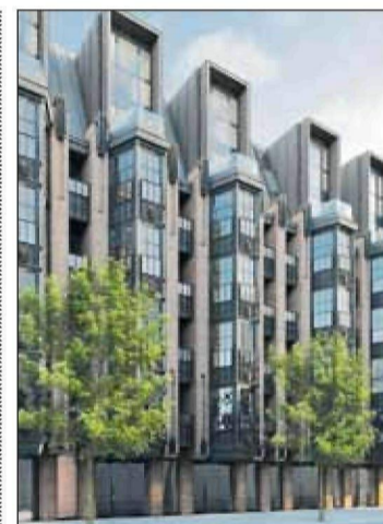
Perła to 7-kondygnacyjny budynek mieszkalny.
