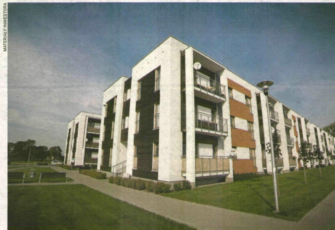
Na Osiedlu Kalinowym mieszkańcom zapewniono automatyczne bramy i podziemne śmietniki
