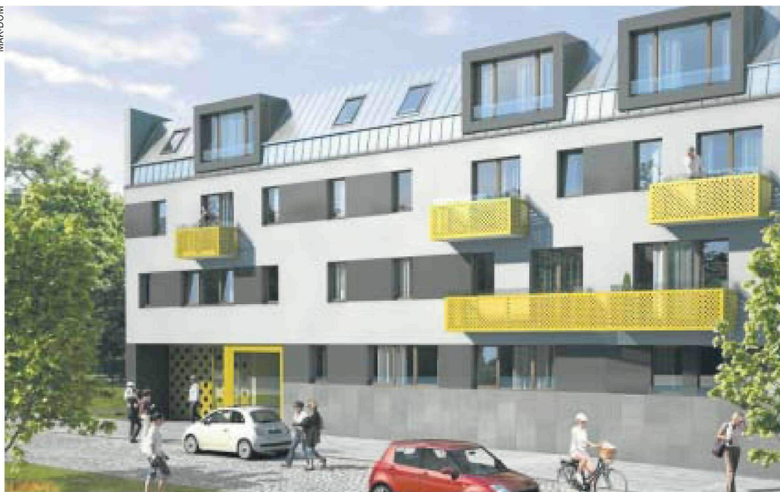
Dwa 3-piętrowe budynki o nazwie Górczyńska 22 postawił w okolicach Głogowskiej deweloper Mak-Dom
