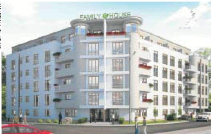
Family House stawia budynek Topaz na Górczynie
